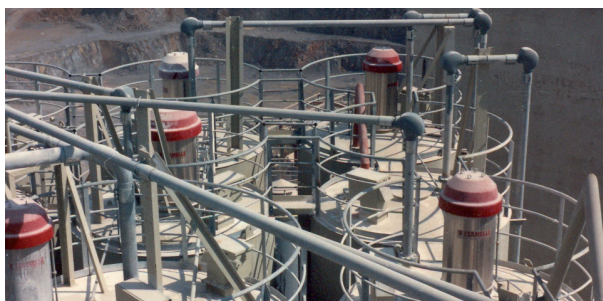
Dépoussiérage de silos avec PNEUFIX et FLOW-BOW®
