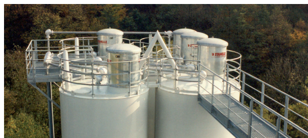
Dépoussiérage des silos avec STAFI®
